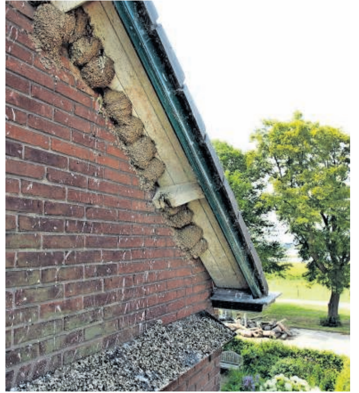
▲ Nesten van huiszwaluwen onder de dakrand. Eronder is een mestplank aangebracht.
