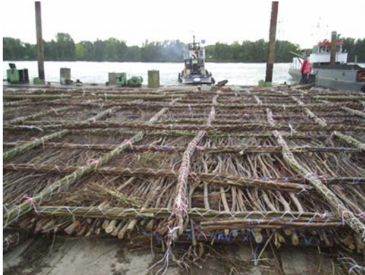
Ook nu nog worden zinkstukken van wilgentenen gebruikt in de dijkenbouw, zoals hier in 2006 bij Sliedrecht
